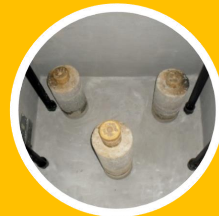
Poços de elevadores
