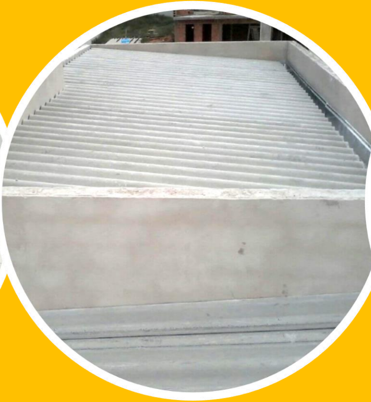
Telhas de fibrocimento
