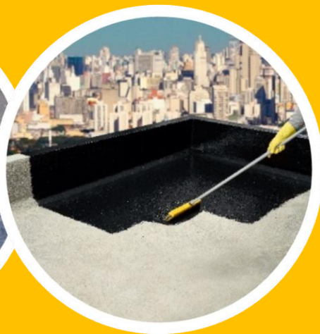
Lajes de coberturas e terraços
