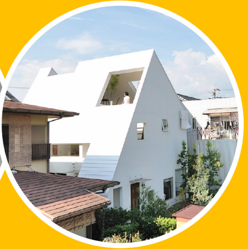
Coberturas inclinadas calhas de concreto
