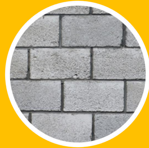
Bloco de concreto
