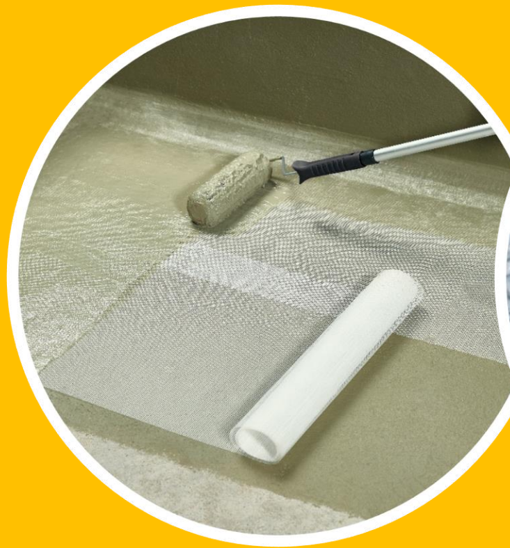
Impermeabilização moldada no local
