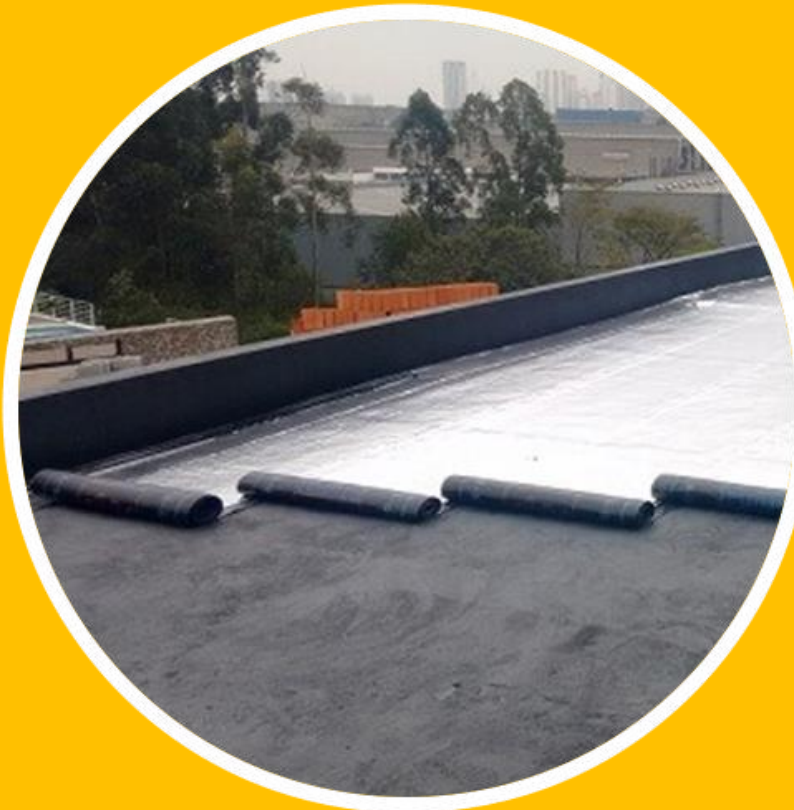
Lajes expostas acima de 100m 2
