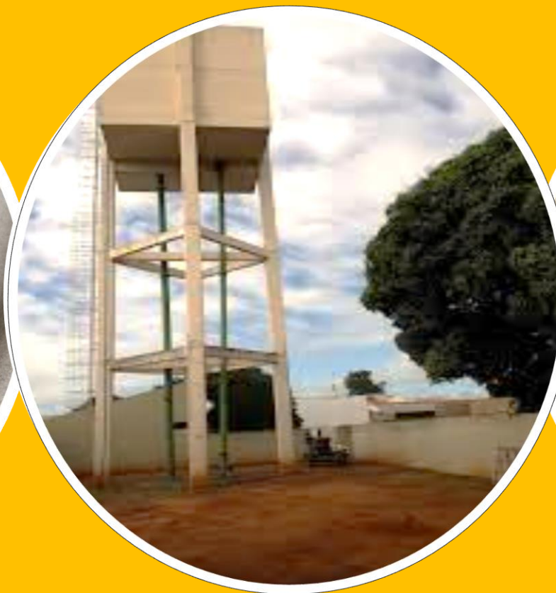
Mantas asfálticas em reservatórios de água e tanques elevados
