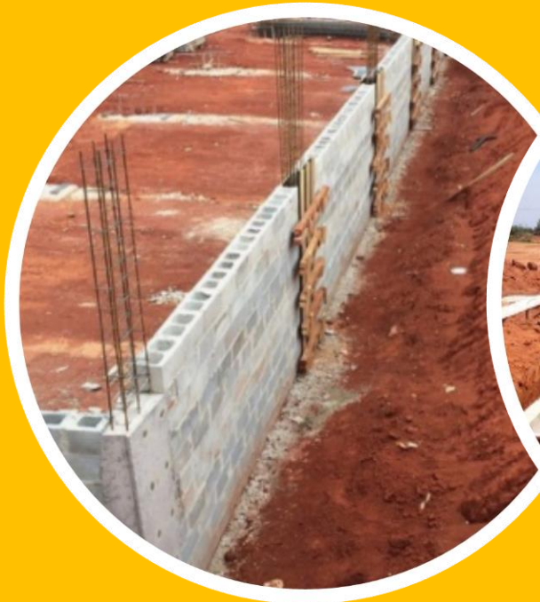
Muro de arrimo
