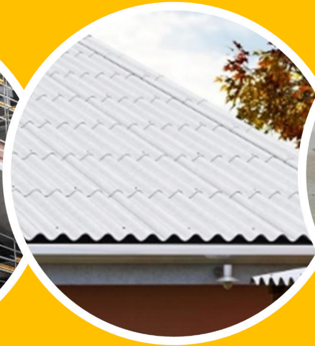
Telhas de fibrocimento
