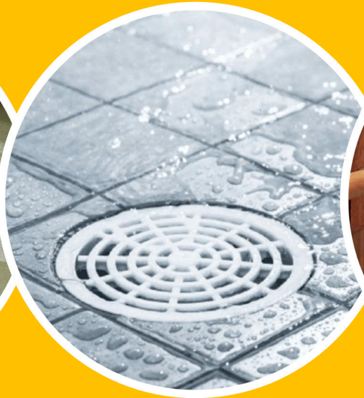
Reforço em pontos críticos de impermeabilização como: juntas, ralos, cantos, arestas e tubos emergentes
