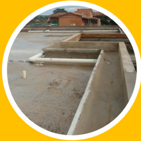
Calhas de concreto
