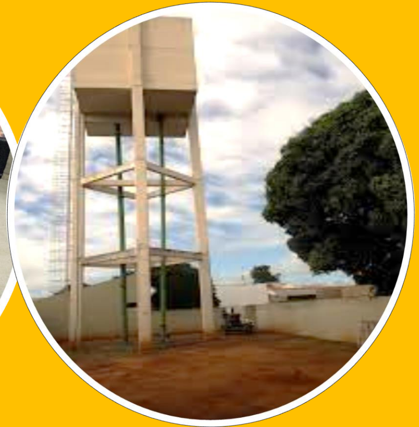
Mantas asfálticas em reservatórios de água e tanques
