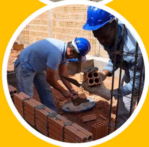
Assentamento de alvenaria
