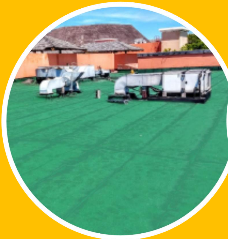
Lajes sem tráfego* (apenas manutenção eventual)
