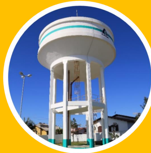
Reservatórios enterrados e elevados
