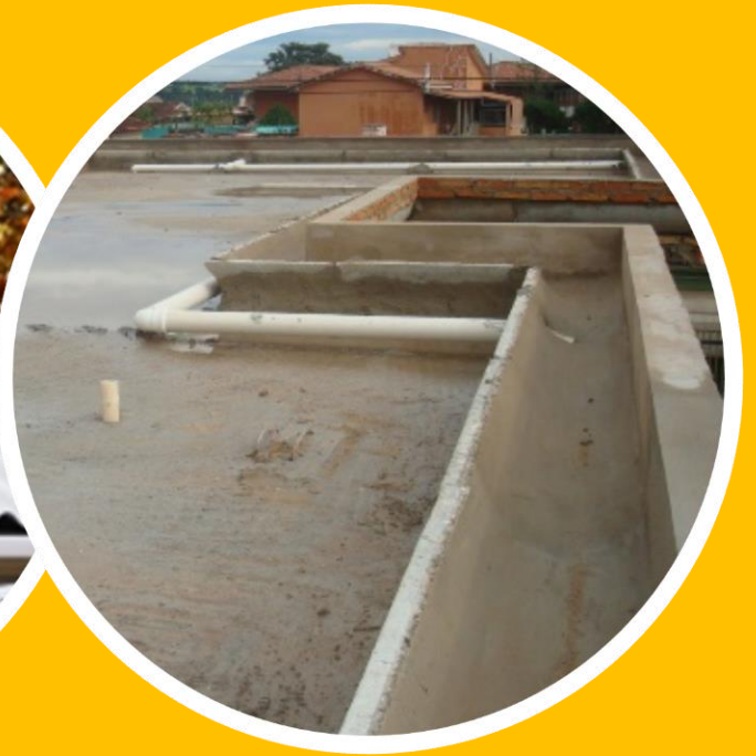
Calhas de concreto
