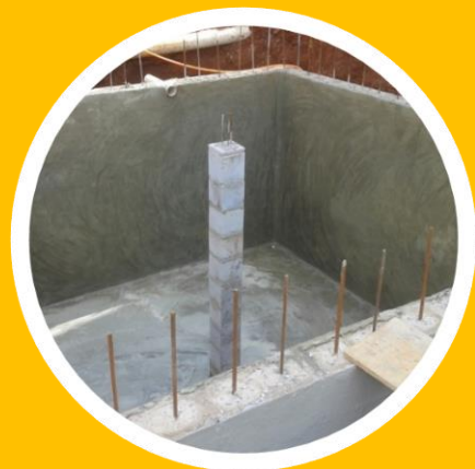
Reservatórios enterrados e Cisternas
