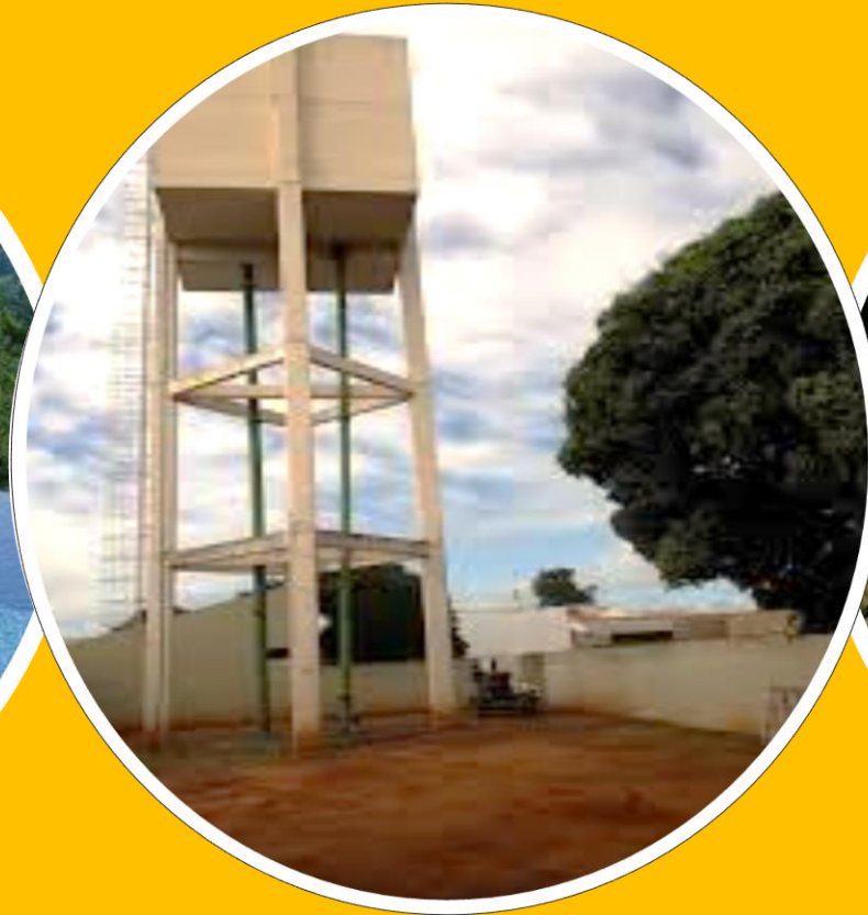
Caixas-d'água, reservatórios e tanques elevados
