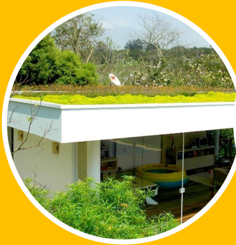
Lajes de cobertura verde
