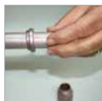
Introduzir a Junta de Vedação no Eletroduto.
