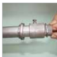
Introduzir o Eletroduto no acessório e apertar o parafuso.
